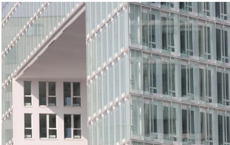
Kompakt-Doppelfassade und Lochfassade am Ericus-Centor
