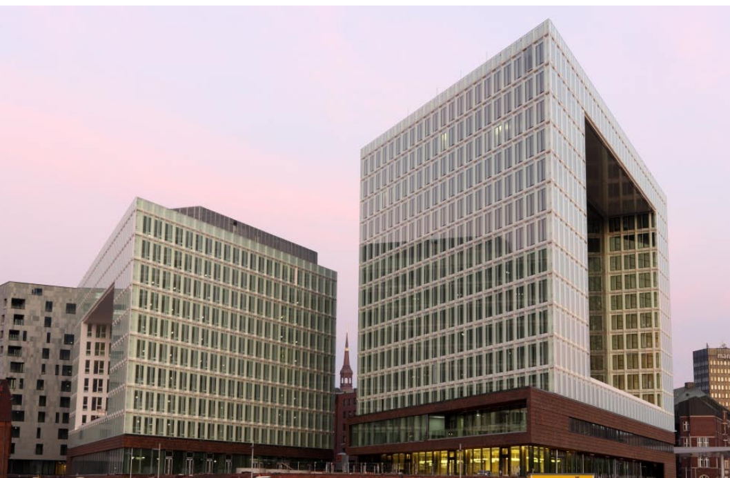
Ericus-Contor und Spiegel-Gebäude mit Doppel-Fassade und zurückgesetztem "Fenster zur Stadt"
