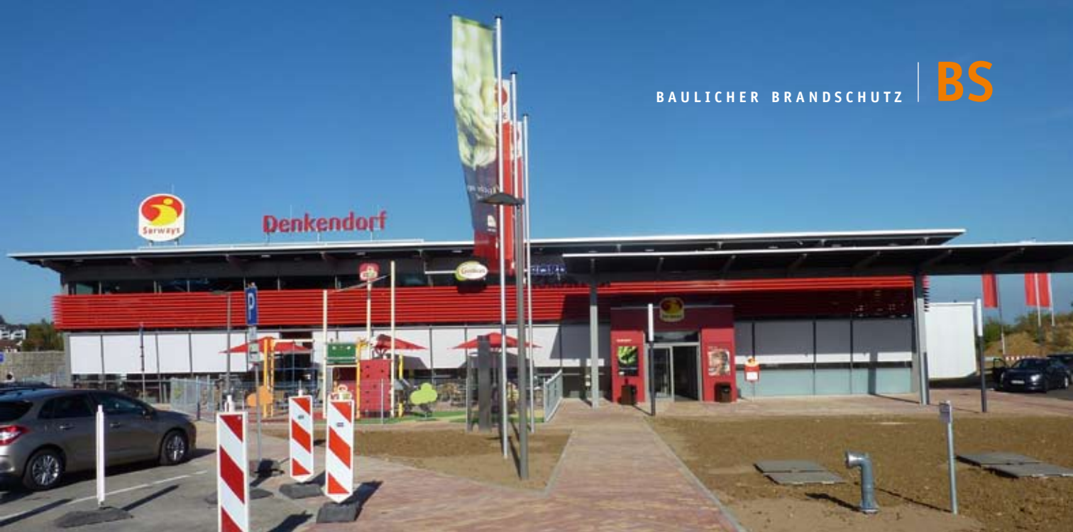
Rastanlage Denkkendorf Nord an der BAB A8 nach Inbetriebnahme
