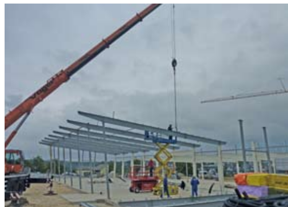
Einbau der plattinierten Stützen und Träger
