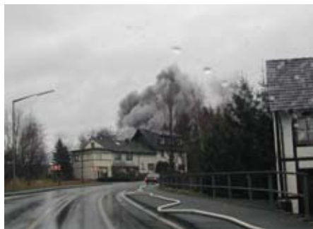
... ein ländlicher Gewerbebetrieb brennt nach Abbrucharbeiten
