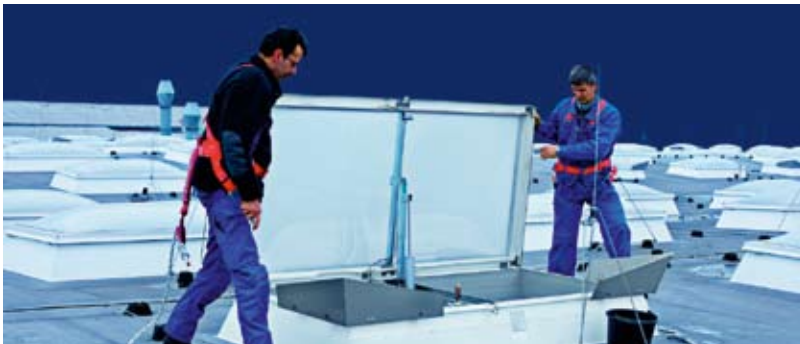
Kontrolle am Oberlicht: Handwerker testen die Belüftungs- und Belichtungsfunktion und überprüfen die eingebauten Personen-Absturz-Sicherungen
