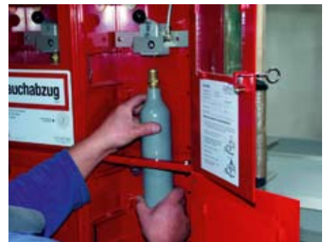
Steuerungszentrale: Austausch schadhafter und verbrauchter Teile sowie deren Ersatz durch Originalbauteile
