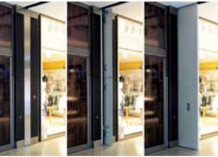
Bild 6: Bei Brand klappt die Edelstahl-Abdeckung auf und das Tor läuft in die Passage
