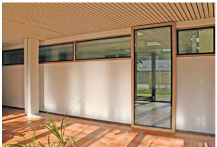
EI30-Brandschutzverglasung schützt Menschen im Falle eines Feuers
