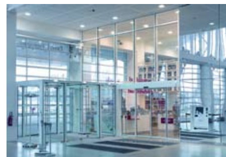
oben: Transparente Glas-Stahl-Konstruktion unten links: In den Brandschutztüren spiegelt sich das Holzgeflecht der Dachkonstruktion
