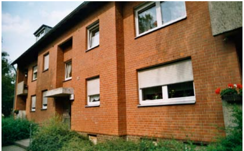
Die UKBS hat als erster großer Vermieter im Kreis Unna alle rund 2800 Wohnungen mit Rauchwarnmeldern ausgestattet – darunter auch das Mehrfamilienhaus, in dem sich der Küchenbrand ereignete
