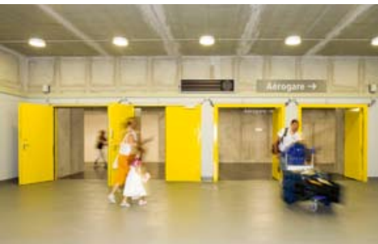
Bild 3: Robust und 90 Minuten Brandwiderstand: Teckentrup T90-2-SV am Luxemburger Flughafen
