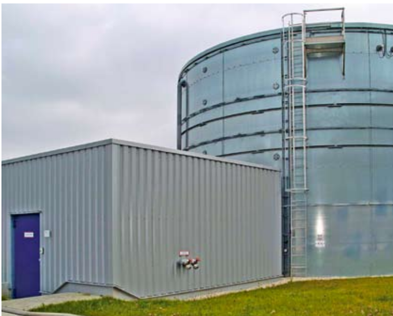
Der Wassertank mit 780 m 3 Inhalt dient als nahezu unerschöpfliche Löschwasserquelle.
