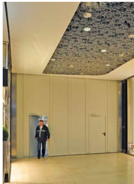
Bild 7: Das Feuerchutz-Schiebetor ist mit Schlupftüren ausgestattet. So ist Personendurchgang auch bei geschlossenem Tor möglich
