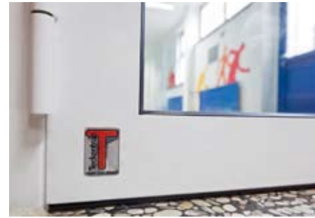
Bild 11: Die Bodendichtung hält bei Rauchentwicklung den brandabgewandten Raum weitgehend frei von Qualm
