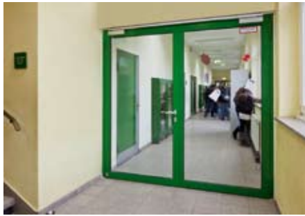
Bild 9: Die Feuerschutztür schließt seitlich an Mauerwerk, oben an eine Leichtbaukonstruktion an
