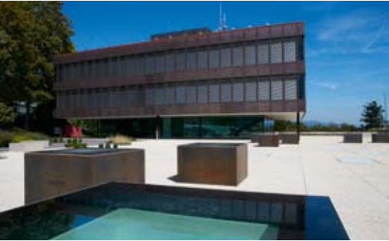
Bei der Sanierung des Hauptgebäudes der EHSM erfüllen Spezialgläser wesentliche Anforderungen an Brand- und Sichtschutz
