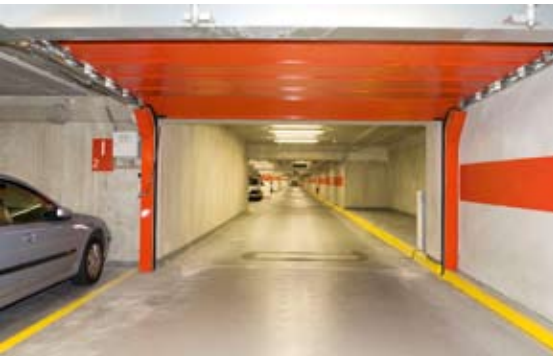
Bild 2: Fehlt der Platz für ein Schiebetor, leisten Sectionaltore den Brandschutz
